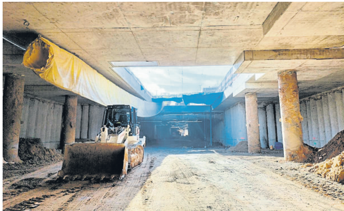
Las obras del túnel que permitirá que el tren pase bajo tierra en la capital del Baix Llobregat
